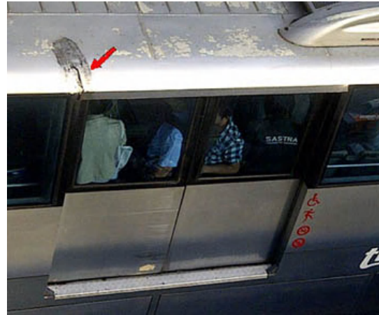
Gambar 2. Retakan pada atap (tanda panah) di atas pilar pintu.
