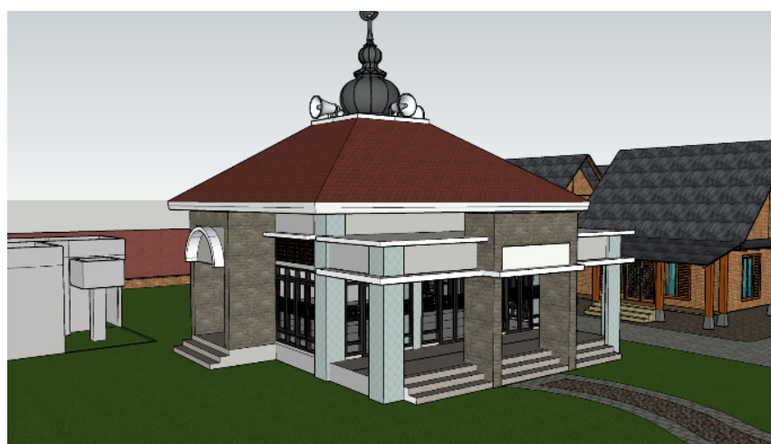
Gambar 8 Masjid Sekolah dengan Penutup atap Genteng Tanah Liat dan Dinding Batu Bata
