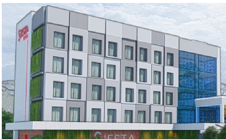
Gambar 8 Fasad Tipikal Lantai Kamar Sisi Selatan atau Depan
