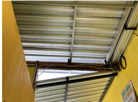
Gambar 11 Kondisi Eksisting Struktur Bangunan Sekolah Luar Biasa Anugerah
