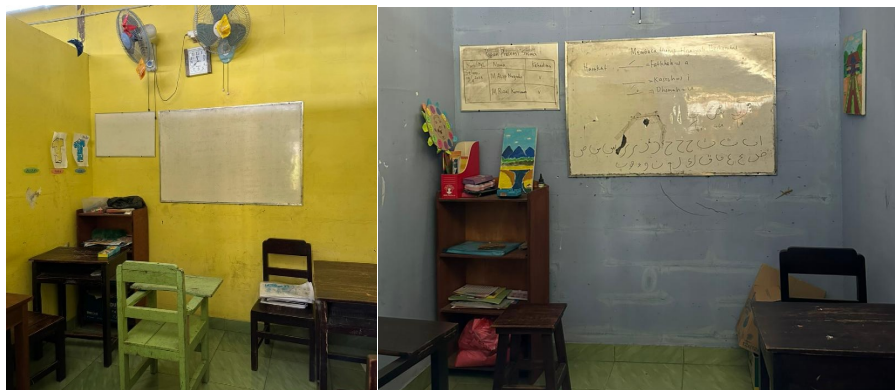
Gambar 8 Kondisi Eksisting Ruang Kelas Sekolah Luar Biasa Anugerah
