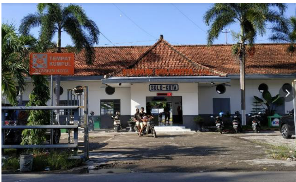
Gambar 2 Tampak Eksisting Stasiun Solo Kota
