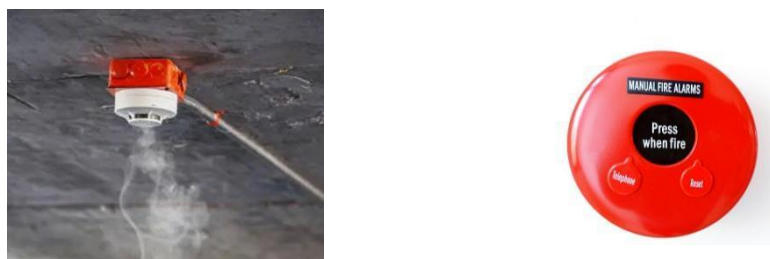
Gambar 8 Fire Detection Otomatis (Kiri) dan Manual (Kanan)
