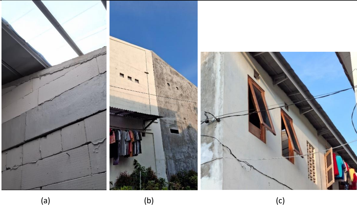
Gambar 8 (a) Atap transparan pada salah satu sisi atap membantu rumah menghemat energi pada siang hari (b) glassblock pada lantai dua (c) bukaan jendela dan rooster membantu sirkulasi udara
