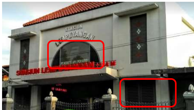
Gambar 6 Bentuk lengkung dan jendela krepyak pada fasad bangunan existing
