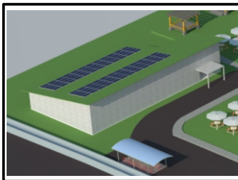
Gambar 7 Green Roof pada bangunan MEE serta Panel surya
