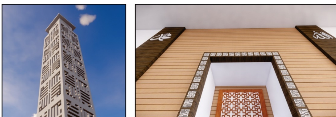
Gambar 7 Penggunaan ornamentasi kaligrafi qufi pada bangunan
