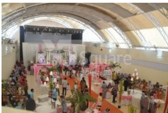
Gambar 7. Struktur bentang lebar yang mendukung fleksibilitas ruang pada area ruang serba guna XT Square Yogyakarta
