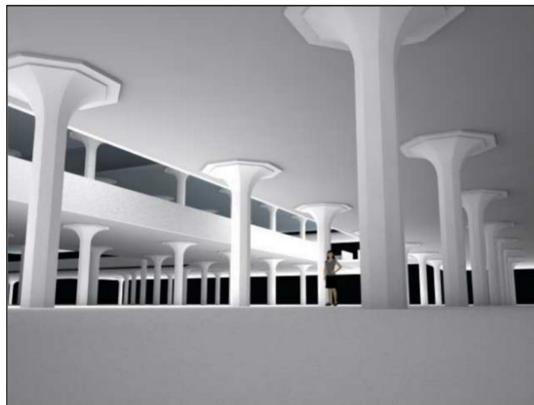
Gambar 13. Rekonstruksi Kolom Pasar Johar Sumber: DTKP Semarang
