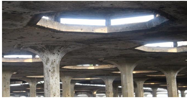
Gambar 5. Ventilasi Pada Atap Pasar Johar
