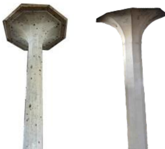
Gambar 7. Kolom Pada Atap Pasar Johar
